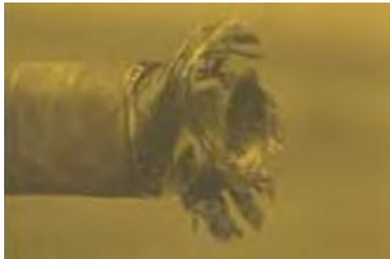
Figura 25: Falha por procedimento incorreto de montagem.
