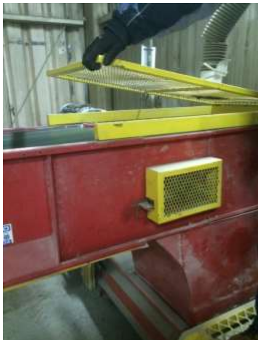
Figura 9: Pormenor da esteira dos silos
