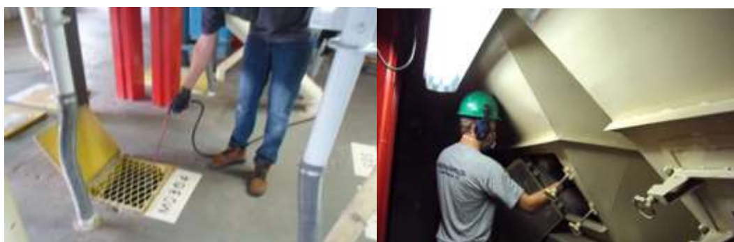
Figura 19: Funcionário realizando a limpeza de um silo e sua moega
